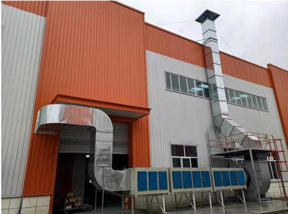
废气处理设施
